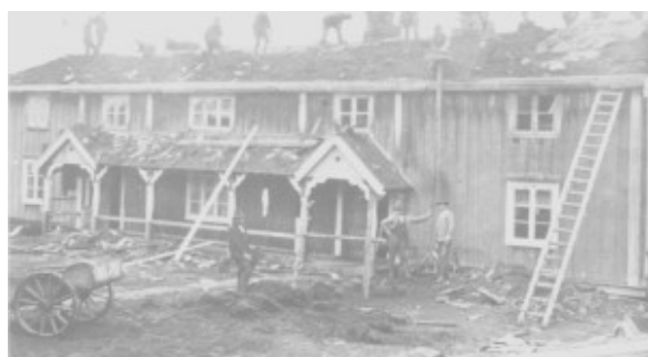
Dugnadsinnsats for å legge nytt tak på hovedbygninga på Aunetrø ca. 1920. Materialene er plankbord, never og torv.
