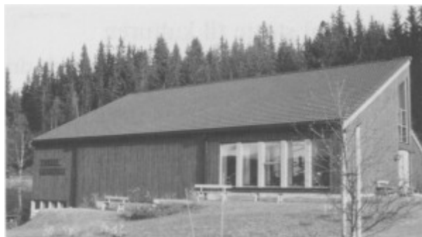
Tydal museums nybygg sto ferdig til bruk i 1990. Det ga bygda gode utstillingslokaler og brannsikre magasiner for gjenstander.
