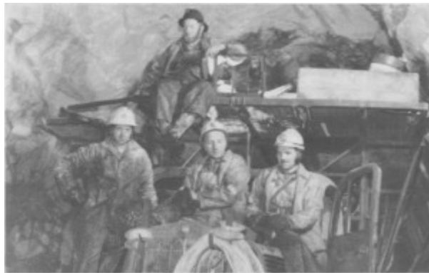
Anleggsarbeidere i tilløpstunnelen ved Nedalsfoss i 1972. Fra venstre Odd Myrmo, Kåre Østby, Tomas Sollien og Arvid Aas.
