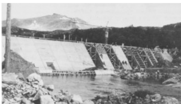
Fra bygginga av inntaksdammen ved Nedalsfoss.
