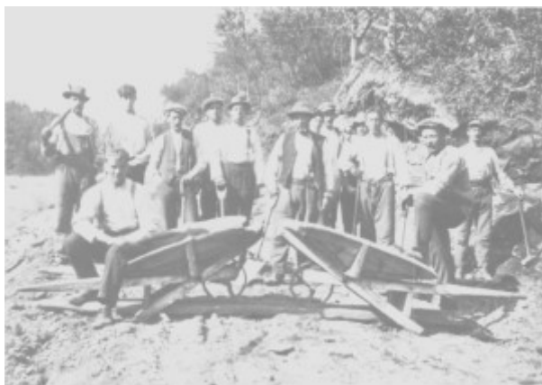
Arbeidslag på Stugudalsvegen 9. juli 1919. Arbeidet foregikk med hakke, spade og trillebåre.
