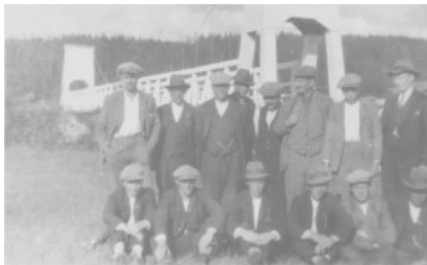
Aune-karene samla ved den nye Henmo-brua som ble bygd i 1926.
